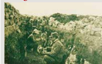
Trincee nella zona di Castelnuovo (Carso).
