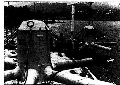
La posa delle cinque unità di ossigenazione « Limno » nel lago di Caldanzon in provincia di Trento alla fine del 1974.
