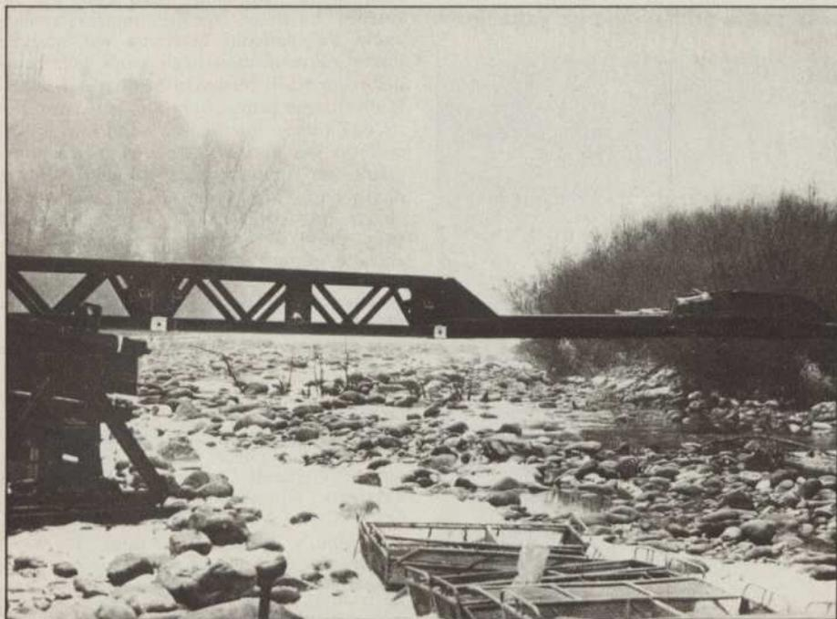
Una fase del montaggio del ponte MGB sul torrente Noce
