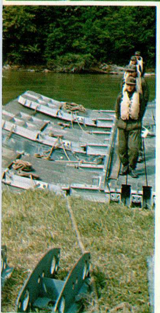
Alcune fasi dell'esercitazione del gittamento del Ponte sull'Adige che consente il traffico a senso unico alternato di mezzi del peso di 60 tonnellate.
