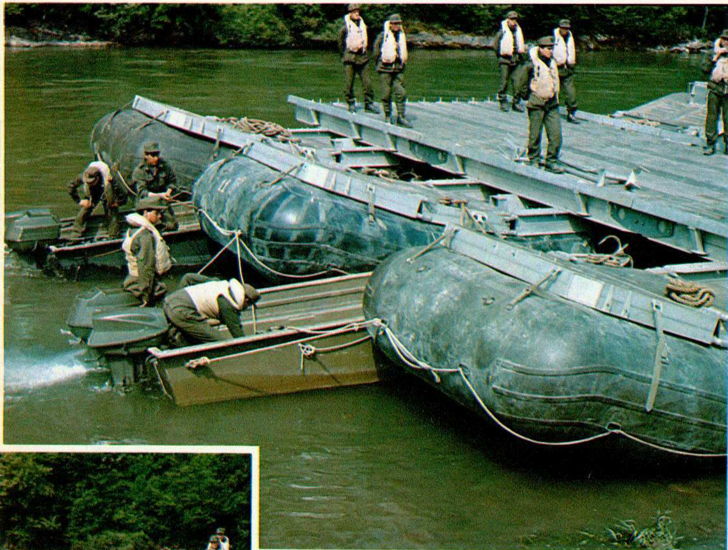
Alcune fasi dell'esercitazione del gittamento del Ponte sull'Adige che consente il traffico a senso unico alternato di mezzi del peso di 60 tonnellate.
