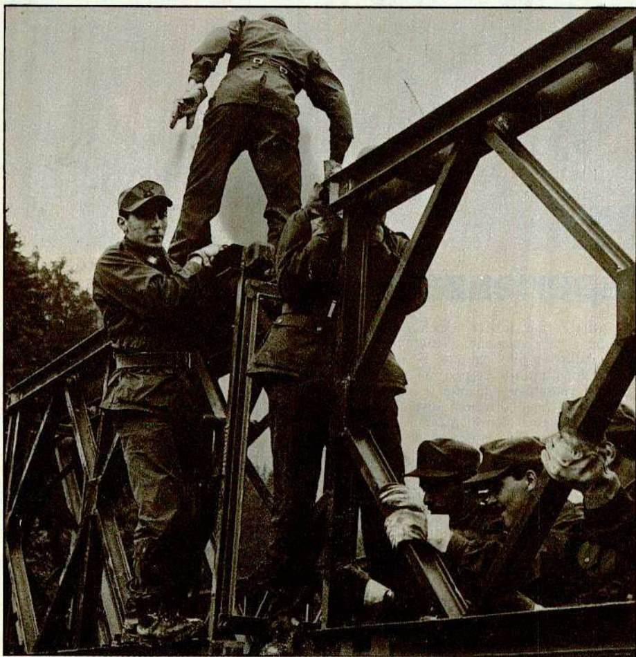
Cinque Ufficiali, 8 Sottufficiali e 130 Genieri del Battaglione Genio «Iseo» in sei ore di intenso lavoro hanno gittato un ponte Bailey lungo 27 metri e della portata di 60 tonnellate sul torrente Gardena nell'abitato di Ortisei. Il ponte, richiesto dall'amministrazione comunale di Ortisei, per far fronte al trasporto di materiali di peso non sopportabile dal ponte esistente in paese, è stato montato interamente a braccia e ha costituito un interessante spettacolo per turisti e valligiani che hanno seguito attentamente il lavoro dei Genieri.
