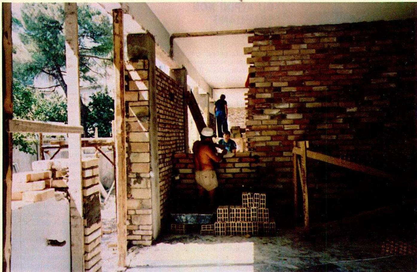
**I muri divisorii sono stati demoliti e sostituiti con altri di spessore doppio**
