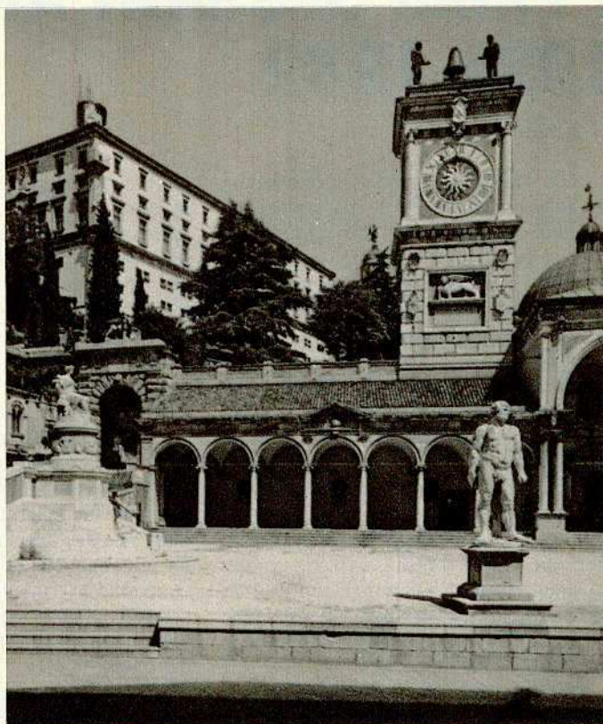
Udine. Portico di San Giovanni con la torre dell'orologio visto dal Palazzo del Comune
