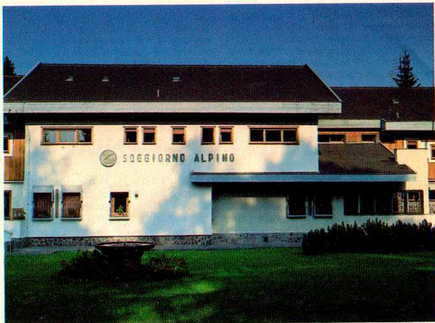
Il moderno, elegante e funzionale fabbricato che ospita il «Soggiorno alpino»
