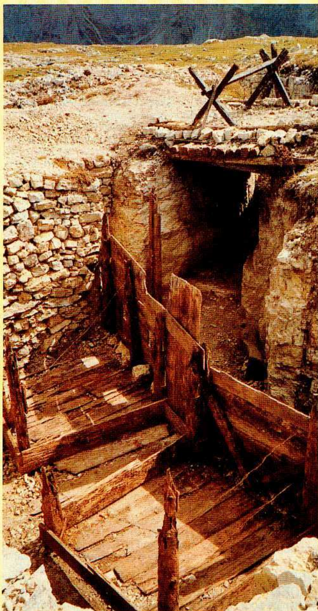
Piana Nord: baraccamento italiano ripristinato interamente con materiale ritrovato in loco.
