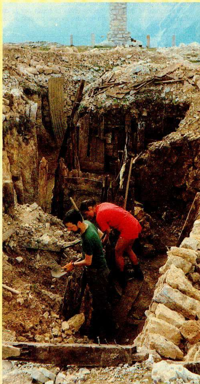
Baraccamento italiano del comandante di settore: volontari al lavoro.
