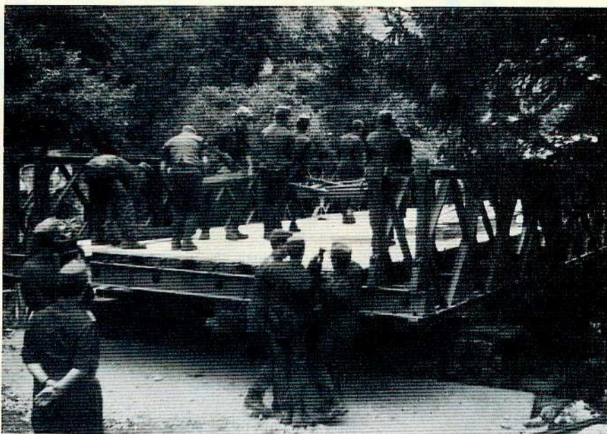
Alta Valtellina, alluvione del luglio 1987; genieri alpini del battaglione «Orta» eseguono il montaggio di un ponte Bailey.
