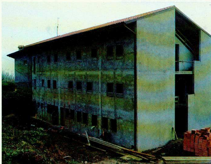
Così ora si presenta il corpo del fabbricato dopo l'intervento dei gruppi alpini della valle Calepio e del basso Sebino.
