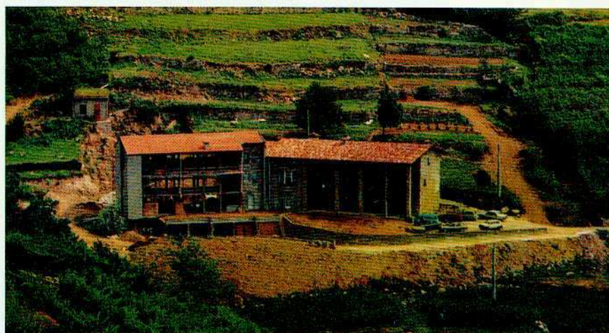
Così si presentava la sede della Comunità Emmaus a Chiuduno (BG) prima che gli alpini decidessero di intervenire. Si può notare nel corpo di fabbricato sulla sinistra che esistevano solamente i piloni portanti.
