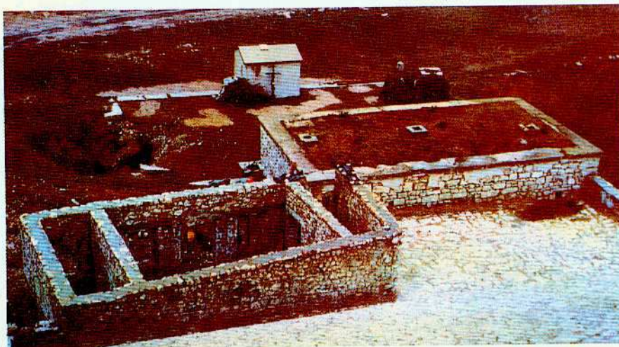
Monte Zugna (m. 1865): cisterne per la raccolta delle acque, costruite dai soldati durante la 1ª guerra mondiale (a sinistra si nota un cratere provocato da un colpo da 420).
