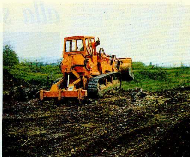
Ruspa in azione per eliminazione di una frana.
