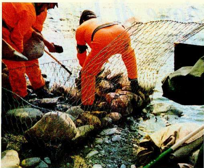
Riempimento di gabbioni per arginare una falla.
