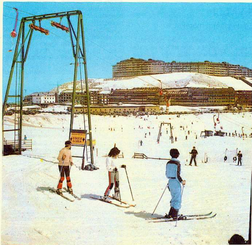
Una delle mostruose costruzioni sorte nei luoghi di sport invernali. Qui siamo a Campitello Matese (prov. di Campobasso)
