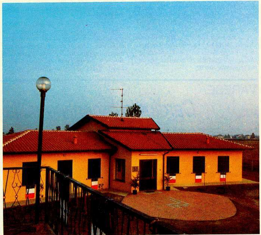
La bella costruzione che ospita il Centro «Col. Paolo Signorini».
