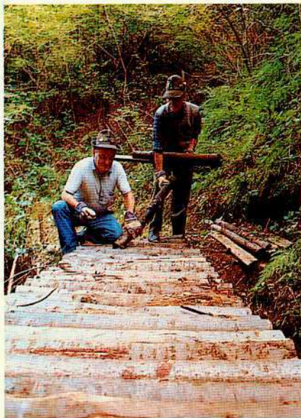
Ponte costruito dagli alpini per superare torrente in zona franata.
