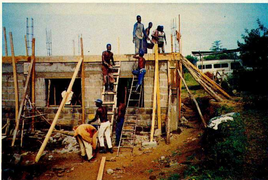
La costruzione dei muri perimetrali dell'infermeria.
