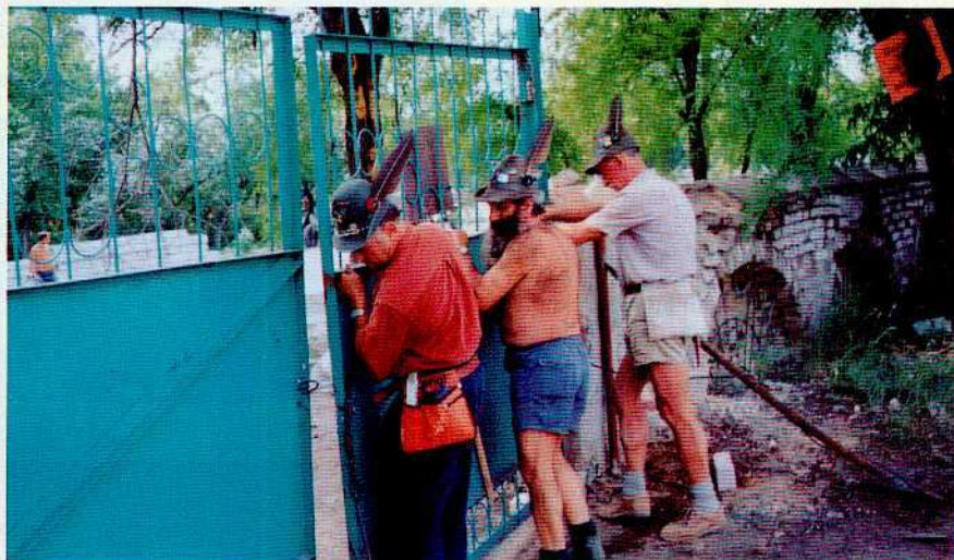
Cantiere ANA di Rossosch, giugno 1992; riparazione del cancello d'ingresso al cantiere dei lavori.
