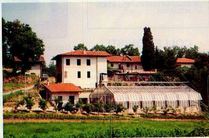
La «Carrubi» a lavori avanzati (giugno 1993)
