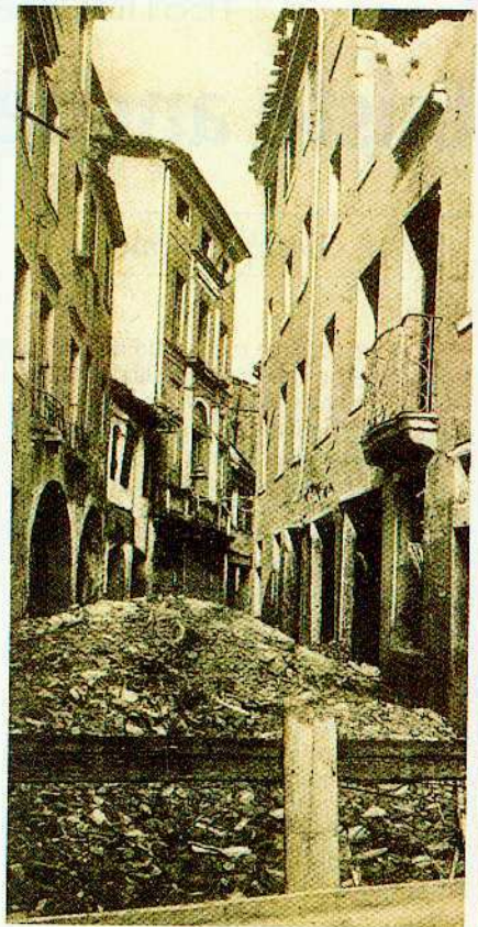
Una strada di Treviso ostruita dalle macerie dopo il bombardamento aereo del '44
