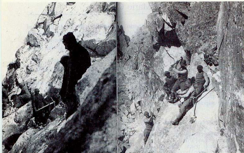
Alpini minatori al lavoro per la costruzione della via ferrata Castellaccio-Payer
