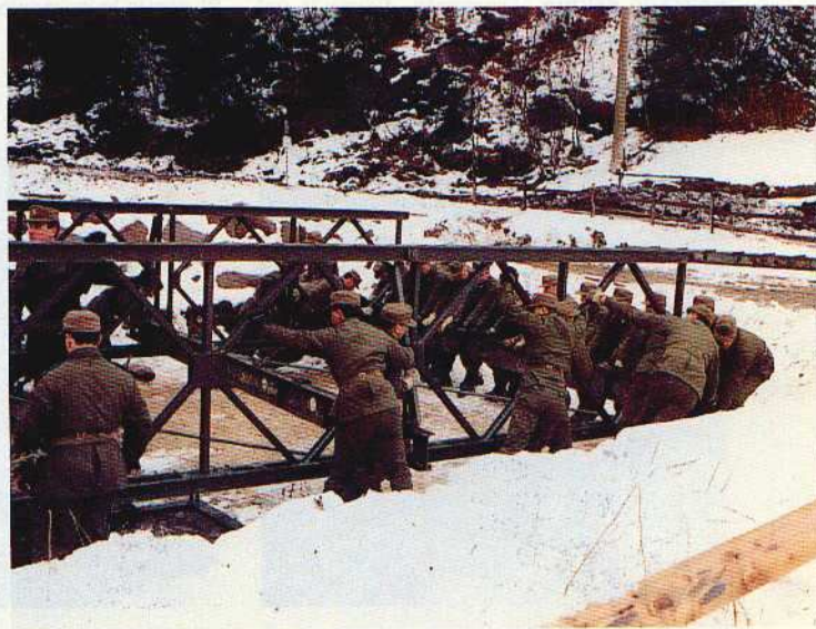
Montaggio di un ponte Bailey sul torrente Noce
