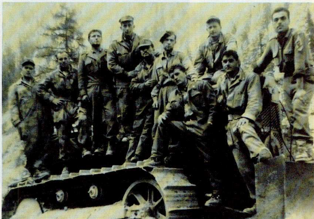
LAVORAVANO A UNA STRADA A SELLA NEVEA
