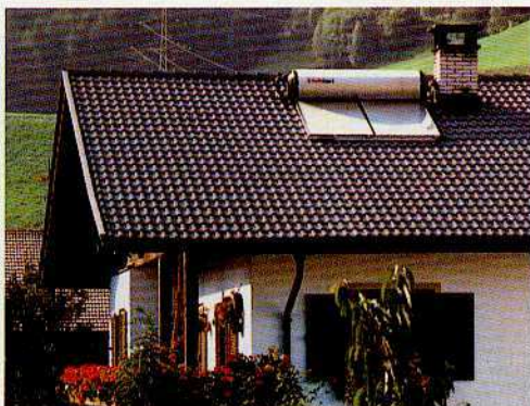
Montaggio serbatoio sopratetto
