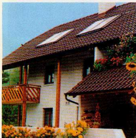
Montaggio serbatoio sottotetto
