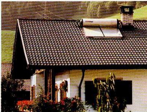
Montaggio serbatoio sopra tetto
