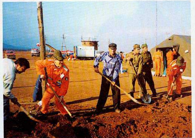
Si scavano buche per i servizi igienici
